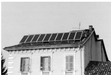
Foto 1 posizionamento sopraelevato non consentito dal presente allegato
