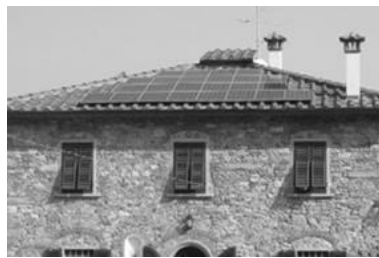
Foto 2 posizionamento secondo la pendenza della copertura, consentito dal presente allegato
