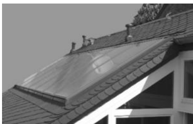
Foto 3 posizionamento secondo la pendenza della copertura: dettaglio
